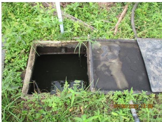
รูปที่ 3-13 ท่อรวบรวมน้ำทิ้งที่ผ่านการบำบัดก่อน ระบายออกสู่ห้วยกรำ
