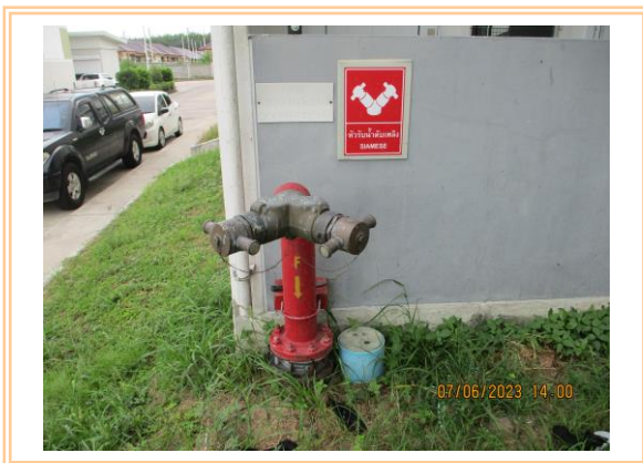
รูปที่ 2.5.2-1 หัวจ่ายน้ำดับเพลิง (Hydrant)
