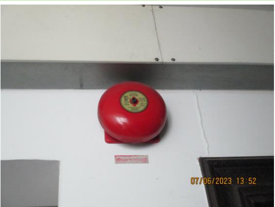
รูปที่ 3-25 สัญญาณแบบกริ่ง (Alarm Bell)
