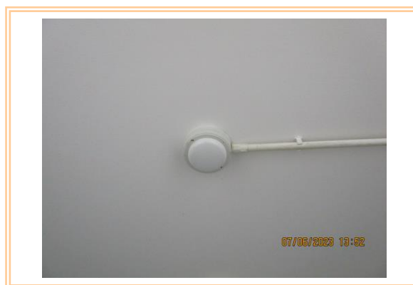
รูปที่ 2.5.9-4 อุปกรณ์ตรวจจับความร้อน
