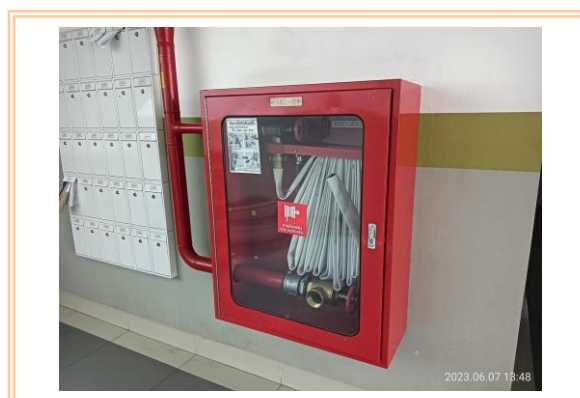
รูปที่ 2.5.9-6 ตู้เก็บสายฉีดน้ำดับเพลิง
