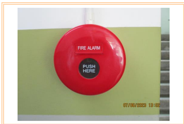
รูปที่ 2.5.9-1 อุปกรณ์แจ้งเหตุแบบใช้มือ
