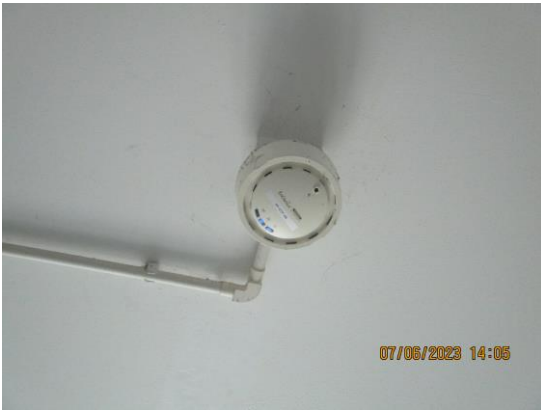
รูปที่ 3-27 เครื่องตรวจจับควัน (Smoke Detector)
