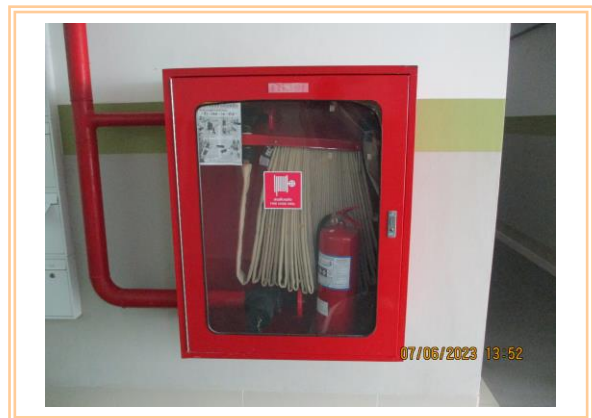
รูปที่ 2.5.2-2 ตู้เก็บสายฉีดน้ำดับเพลิง
