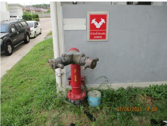
รูปที่ 3-29 ท่อรับน้ำดับเพลิง
