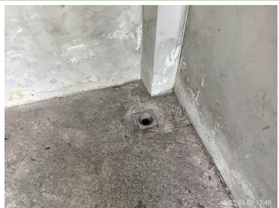
รูปที่ 3-20 ท่อระบายน้ำเสียจากการชะล้างห้องพักมูลฝอย
